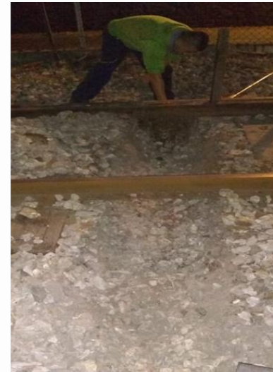
Balasto Contaminado y sin aristas (boleado)
