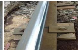
Fijación de la Vía
