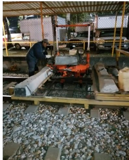
Cambio de Durmientes Dañados
