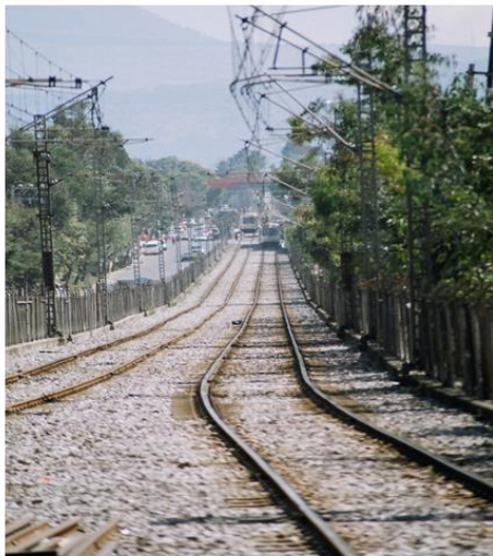
Traza de la Vía del Tren Ligero en Tramo 2, obsérvese la falta de alineación y nivelación
