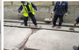
Tirante de Vía utilizado para asegurar el ancho de Trocha
